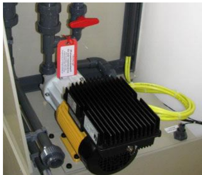
Abbildung 21, Förderpumpe mit Frequenzumr.
